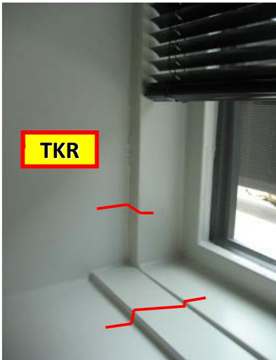
Kuva 5. Ikkunaliittymien lisätiivistys on tehty valkoisella TKR-pinnoitteella.
