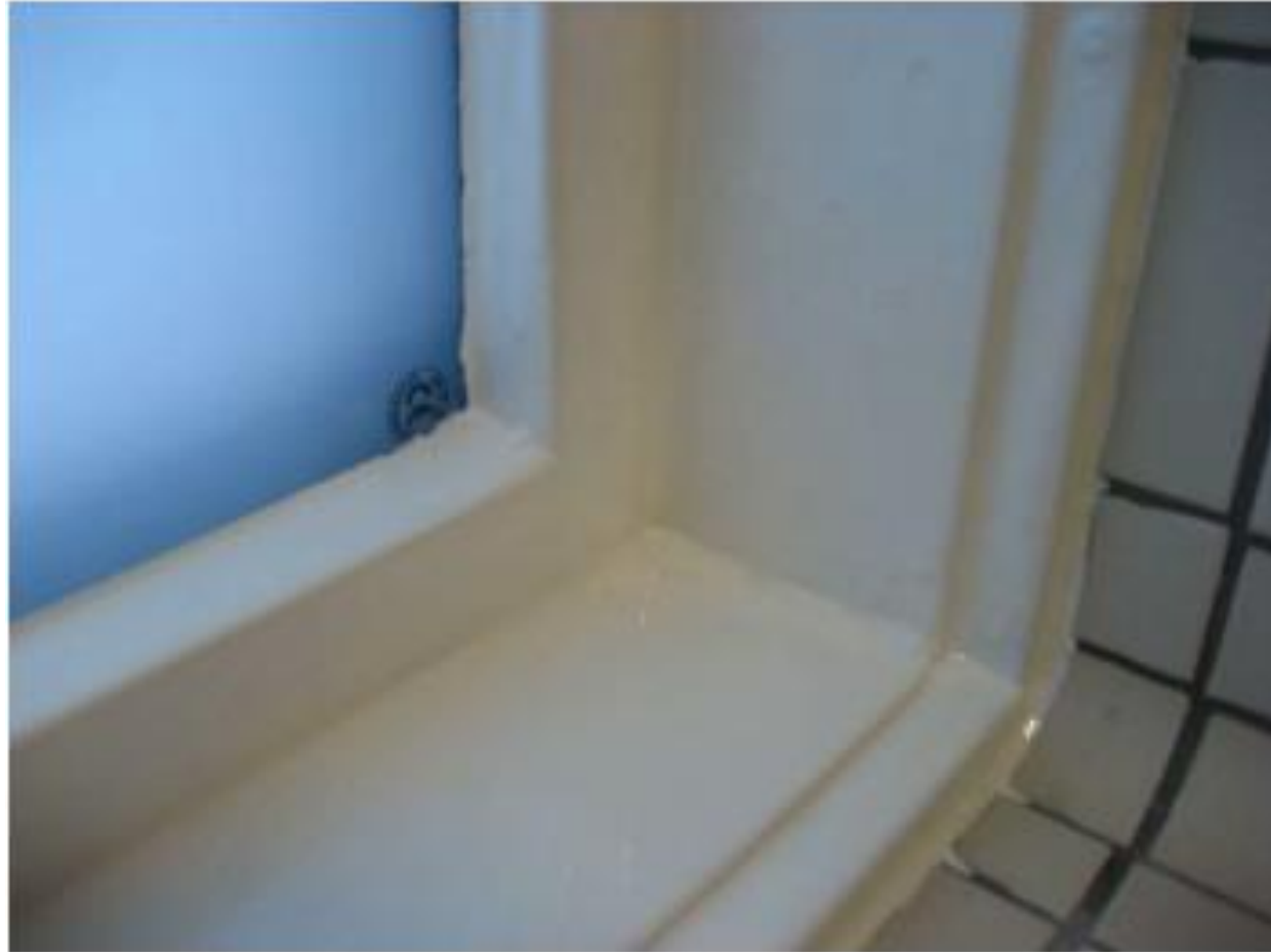
Kuva 5. Ikkunaliittymien lisätiivistys on tehty valkoisella TKR-pinnoitteella.
